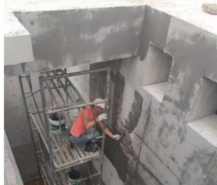
防渗施工现场照片（防腐涂料施工）
