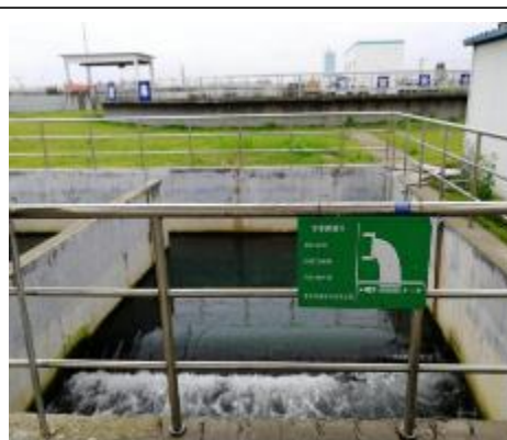
厂区污水排放口
