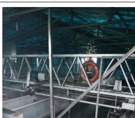
厂区污水进口
