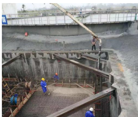
防渗施工现场照片（混凝土浇筑）
