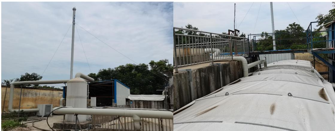
废气加盖收集系统+除臭喷淋塔+低温等离子除臭装置+15m高排气筒
