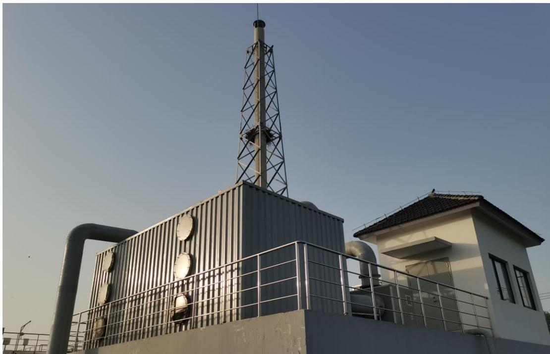
生物滤池除臭装置及 15m 排气筒有组织排放
