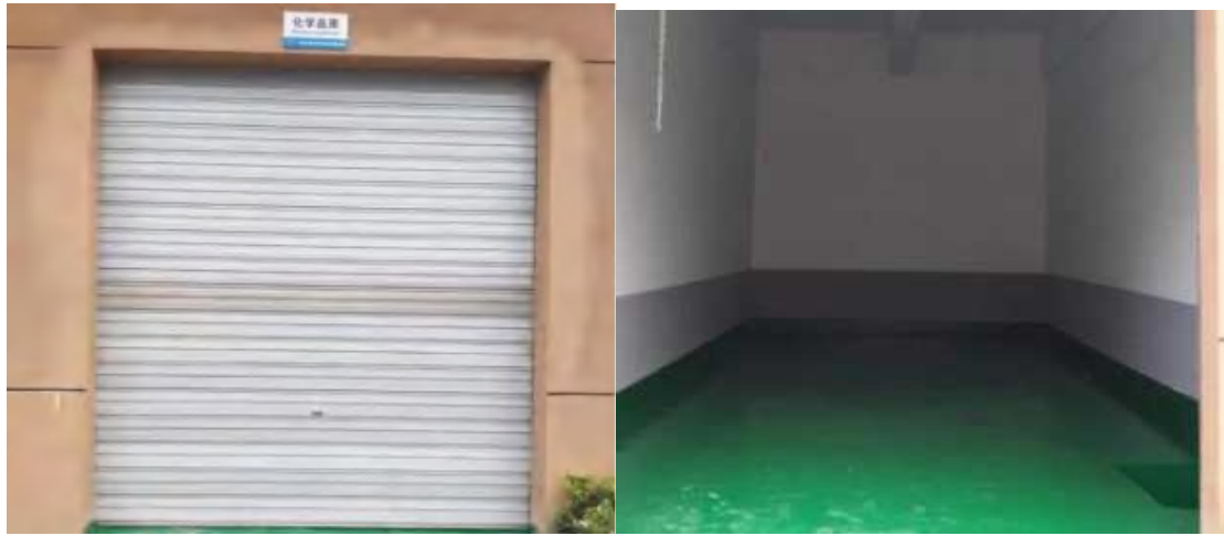
化学品库（防腐防渗地面、导流渠、积液坑、标识等）
