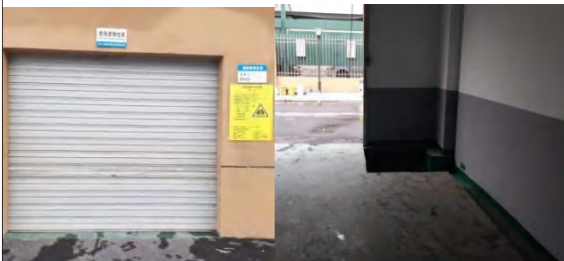
危废仓库（防腐防渗地面、导流渠、积液坑、标识等）
